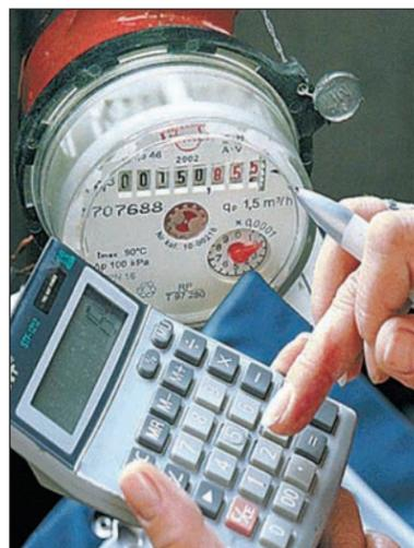
Не подлежит поверке водосчетчик в случаях отпотевания стекла, наличия воды в стенах механизма, неравномерного вращения или сбоях в направлении, если счетчик вообще не вращается. При таких неполадках придется купить новый прибор.
