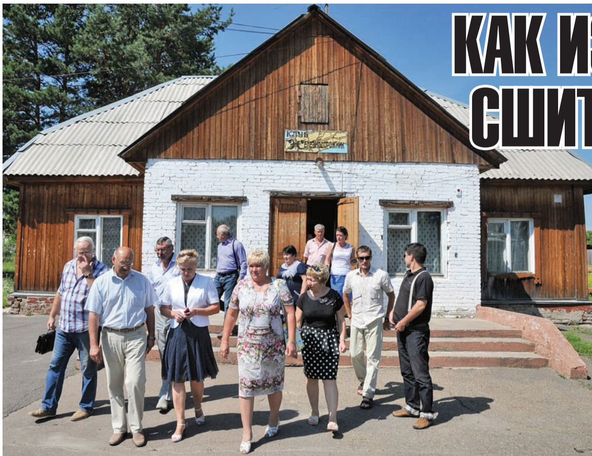
На завершение строительных работ в клубе «Старт» требуется 23 миллиона бюджетных рублей.
