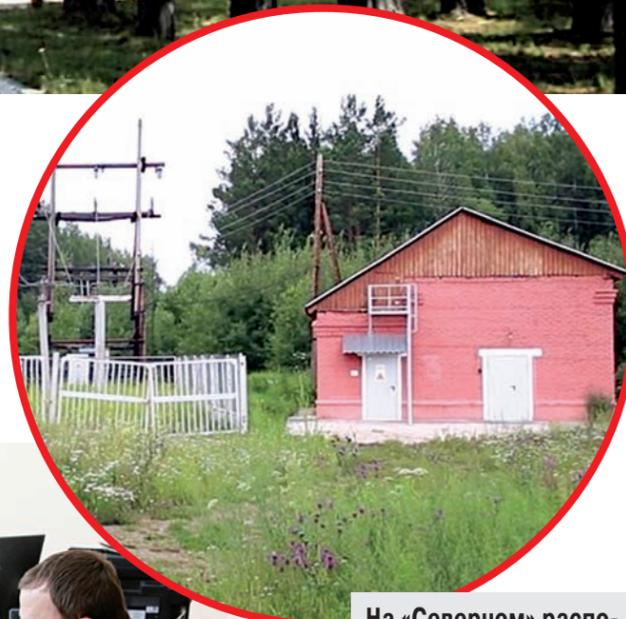
На «Северном» расположено 164 скважины трех типов: нагнетательные, разгрузочные, наблюдательные. Павильон нагнетательной скважины для закачки ЖРО в первый горизонт на глубину до 500 метров.
