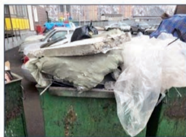
Складируют строительные отходы в контейнеры для ТКО
