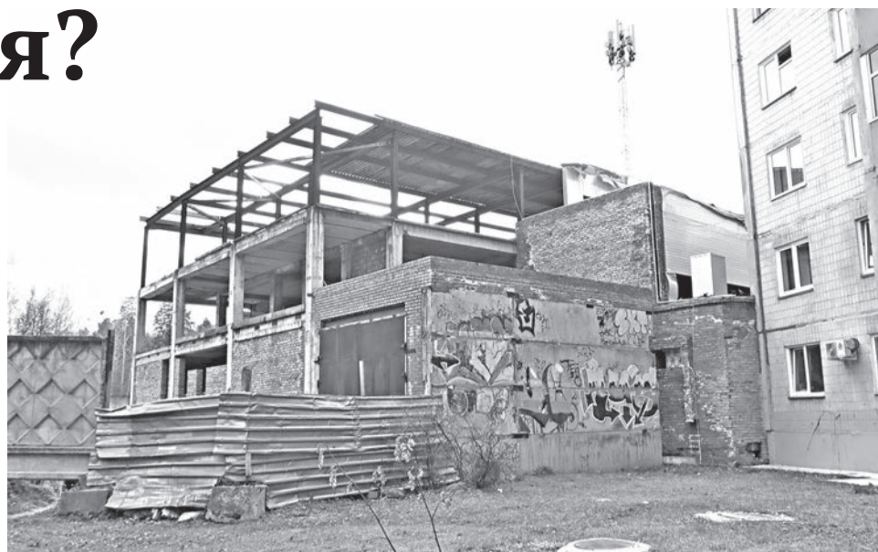
Забор вокруг стройки вандалам не помеха. ▲
