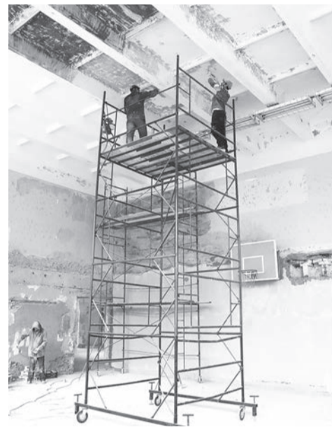
▲ Высотные работы в спортзале.
