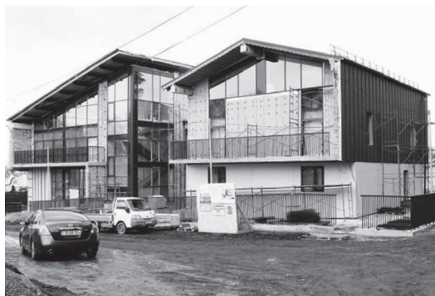
▲ При строительстве корпусов сервисного центра лыжного комплекса «Воробьи» используются материалы, отражающие природное окружение здания – камень, дерево.
