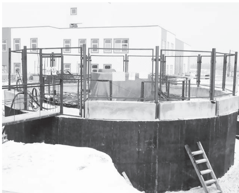
▲ Так сегодня выглядит устье вентиляционного ствола лаборатории.
