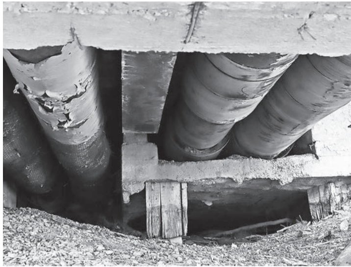
▲ Под тротуаром проходит теплосеть. И вода, проникая сквозь трещины в асфальте, размывает грунт.
