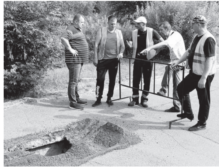
▲ Под тротуаром проходит теплосеть. И вода, проникая сквозь трещины в асфальте, размывает грунт.
